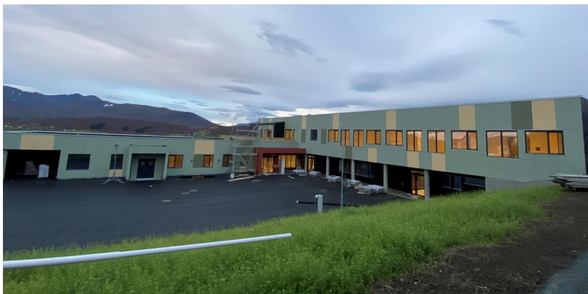
Figur 1: Helsehus under oppføring
