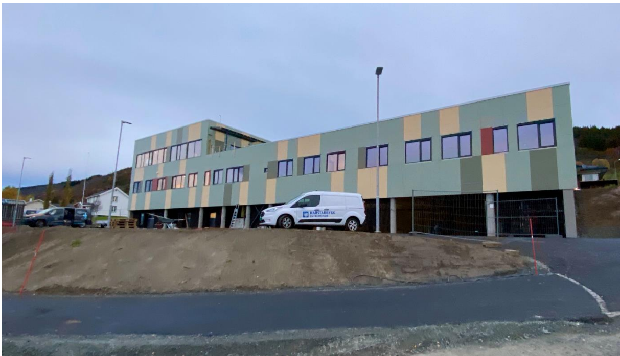
Figur 10: Helsehus under oppføring
